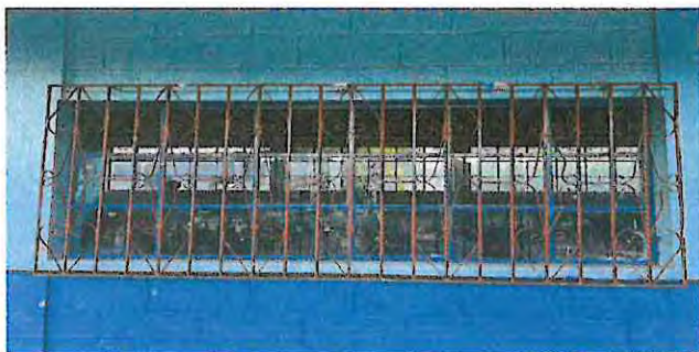
Foto 5: Mantenimiento a valcones
