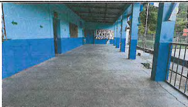
Foto 3: SUSTITUCIÓN DE BARANDA DE METAL EN CORREDOR.
