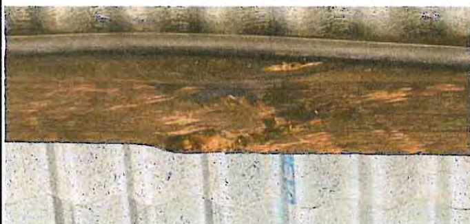
Foto 3: Vigas de madera en interior de aulas.
