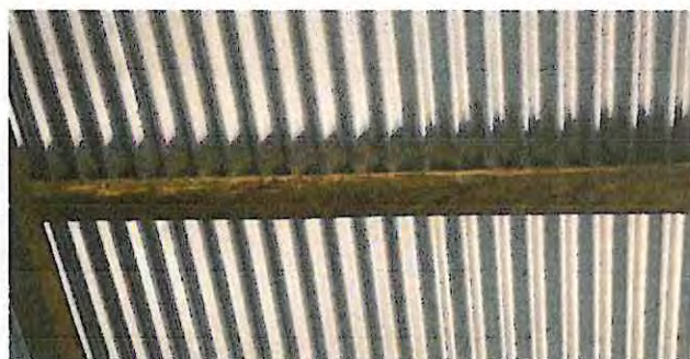
Foto 4: Vigas en corredor.
