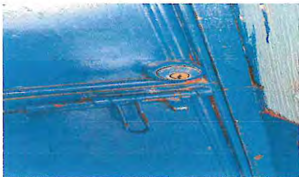
Foto1: SUSTITUCION DE CHAPA EN PUERTA DE AULA 1
